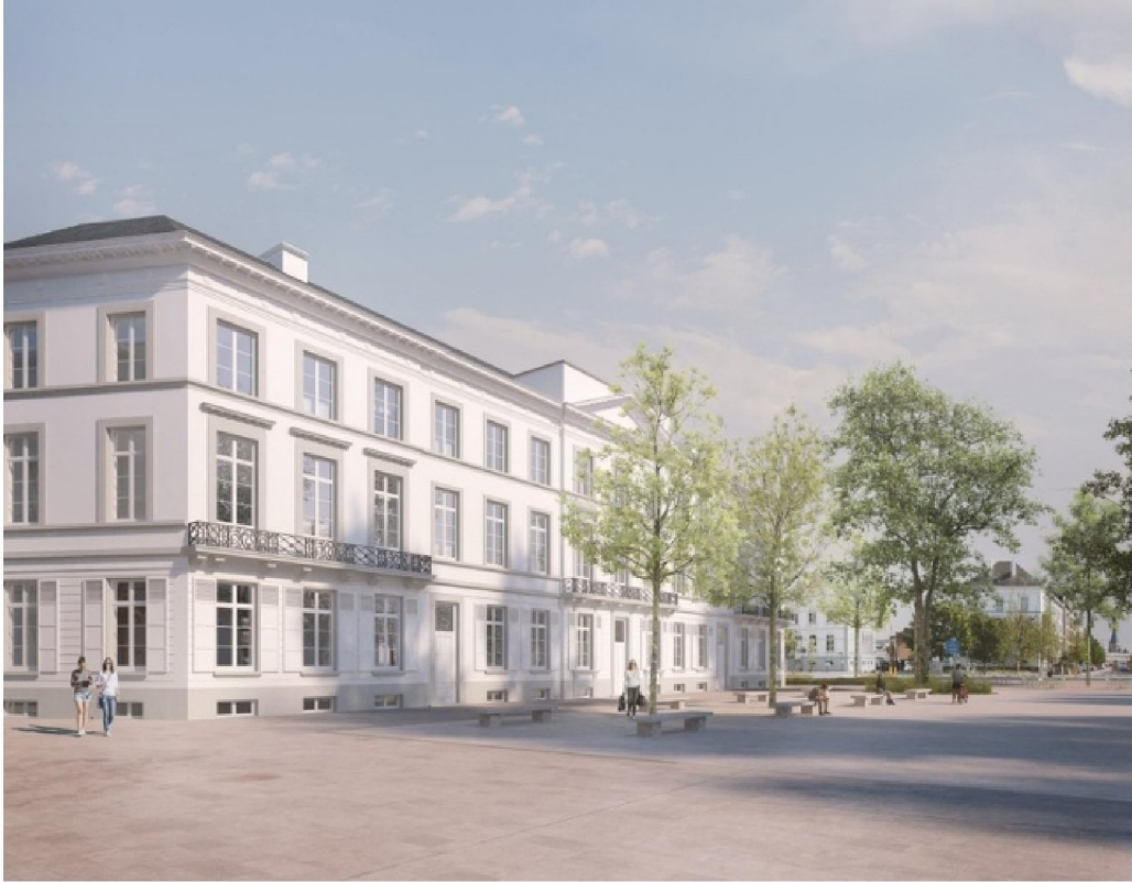
De historische vleugel krijgt opnieuw drie toegangsdeuren. — © a2o architecten
